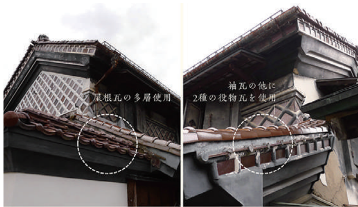
大沼正之家店蔵、北側裏面（写真左）と南側裏面（写真右）、2018/11/20
